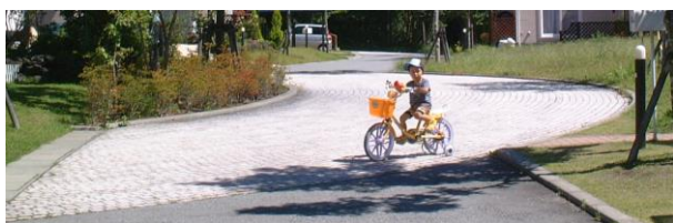
湾曲した道路にピンコロ舗装
